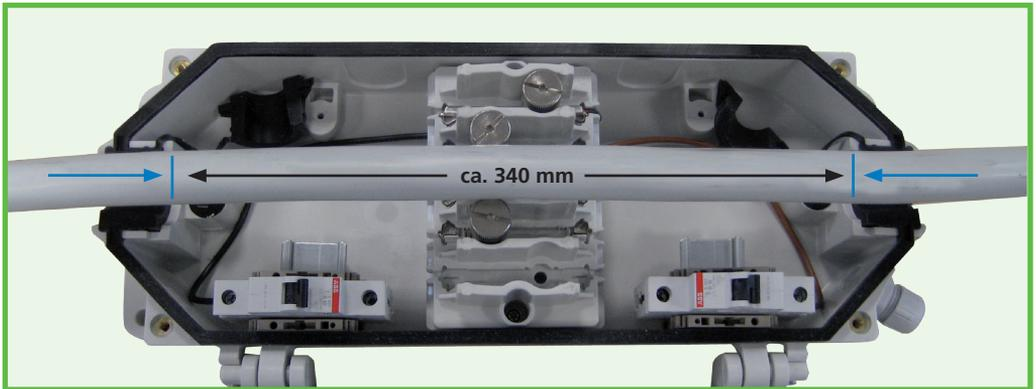
Nach dem Entfernen des Mantels müssen die Einzeladern aufgebogen und in die vorgesehenen Kammern der Klemme positioniert werden. An den entsprechenden Kontaktierungspunkten ist die Leitung abzuisolieren. Bei der 16 mm<sup>2</sup> Klemme muss die abisolierte Stelle eine Breite von 18 bis 23 mm aufweisen. Die 50 mm<sup>2</sup> Klemme benötigt eine Freifläche von 21 bis 26 mm. Auch hier ist ein vorheriges Markieren vorteilhaft.
