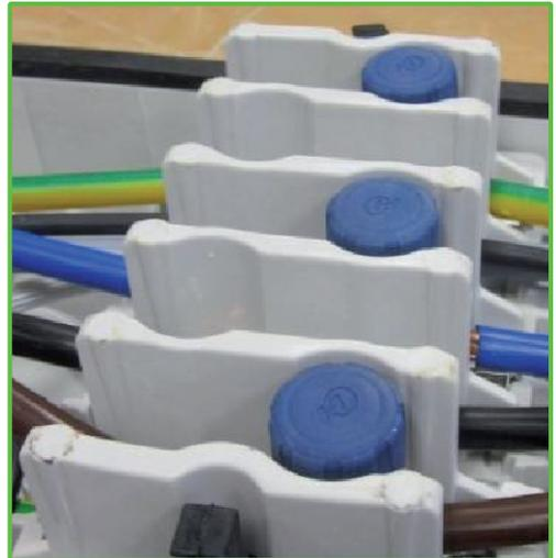
Zum Schließen des Gehäuses müssen die Halbschalen der Dichtung in Position gebracht werden um anschließend den Deckel zuzuklappen. Jegliche Verschmutzungen an der Dichtung müssen entfernt werden und die Dichtungshalbschalen müssen sauber aufeinander liegen um eine optimale Abdichtung zu gewährleisten.
